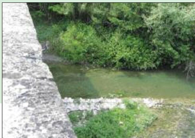
Prise d'eau du canal en amont du pont de La Laupie.
