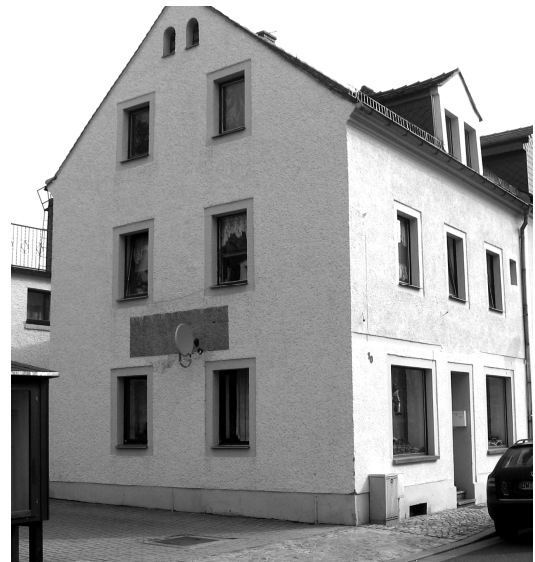
Dieses Haus besitzt kein Wärmeschutzverbundsystem....
