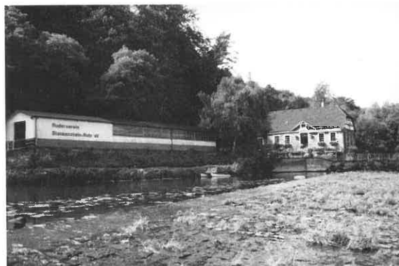
Die erweiterte Bootshalle 1985
