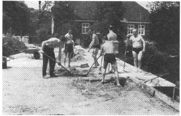
Der Super-Sommer 1964 begünstigte den Neubau; Aktive beim Gießen der Fundamente.
