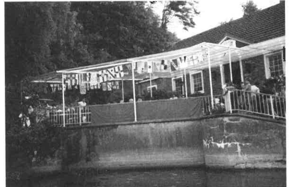
Die mobile Überdachung des Vorplatzes
