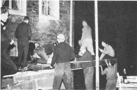
In einer Nacht des Jahres 1963 wurden Eisenkonstruktion und Schalung der neuen Terrasse erstellt.
