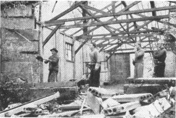
Abbrechen ist leichter als Aufbauen. 1964 fallen die Mauern der alten Halle.
