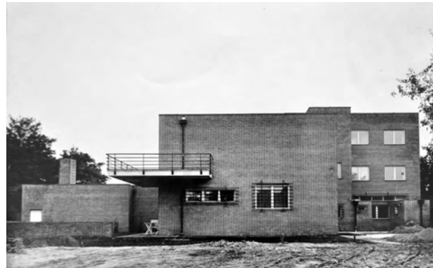
Straßenfassade/ Street elevation/ Elewacja ulicy Mies van der Rohe Archive, Museum of Modern Art, New York.
