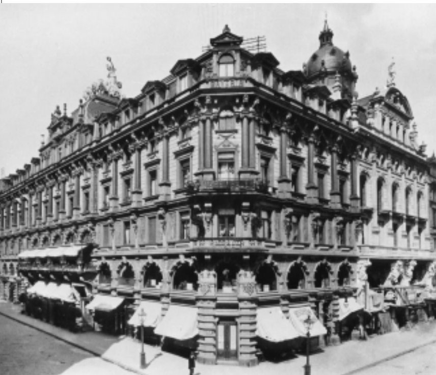
Bavariahaus, Schillerstraße 2/Schillerplatz, und Alemanniahaus, Schillerplatz 4-6. Keller, 1891.
