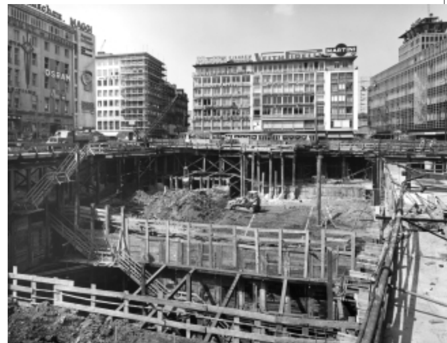
U-Bahnbaustelle Hauptwache. Klaus Meier-Ude, 1967.
