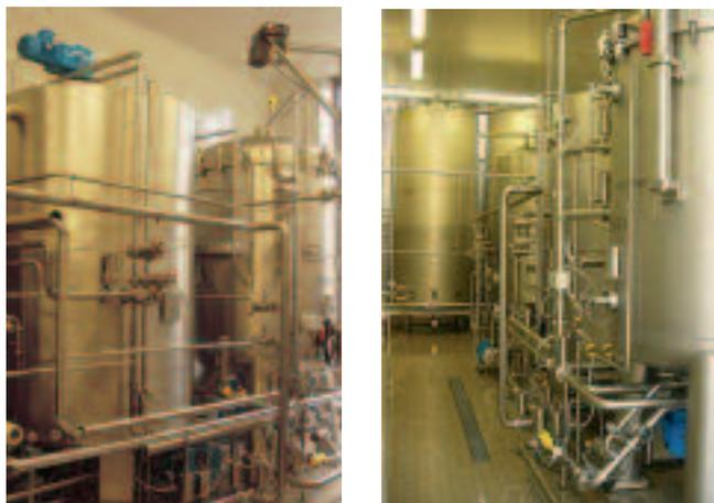
Abb. 2: Filterlinie mit dem Kieselgurfilter ZHF Primus III für regenerierbare Filterhilfsmittel und dem Stapeldosiertank sowie CIP-Tanks in der Altenburger Brauerei
