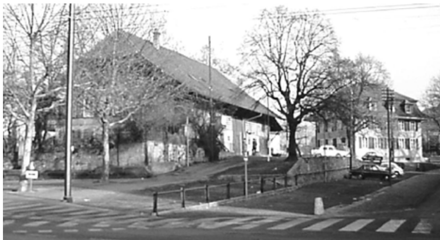
Grabenscheune und Kindergarten, 1972, kurz vor dem Abbruch
