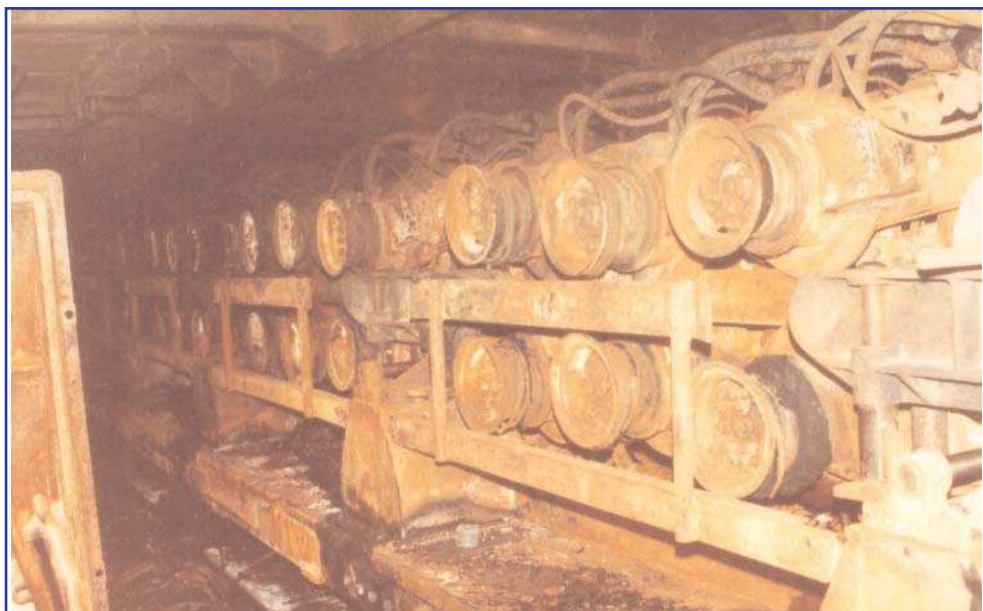
Machine de pose arrière
