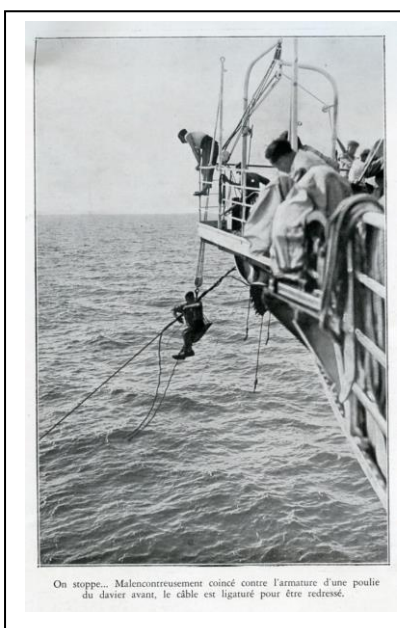
Fig 29, 30, 31 & 32 – Le bossage du câble à l'extérieur, le jointage, le passage de la boucle au davier et la libération de l'épissure finale (Photos L'illustration).
