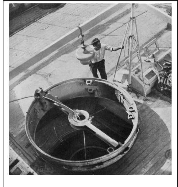
Fig 23, 24 & 25 - La pose du câble par l'arrière (Photos L'illustration).
