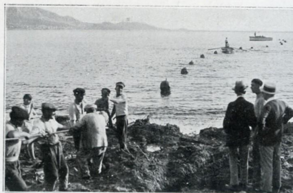
L'amarrage en terre de France de l'extrémité du câble que l'Ampère va poser jusqu'en Algérie.
