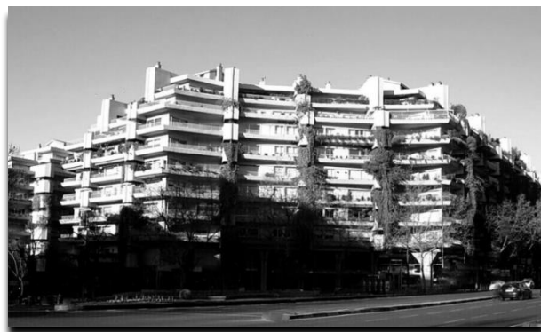
El inmueble fue diseñado por el arquitecto Fernando Higueras
