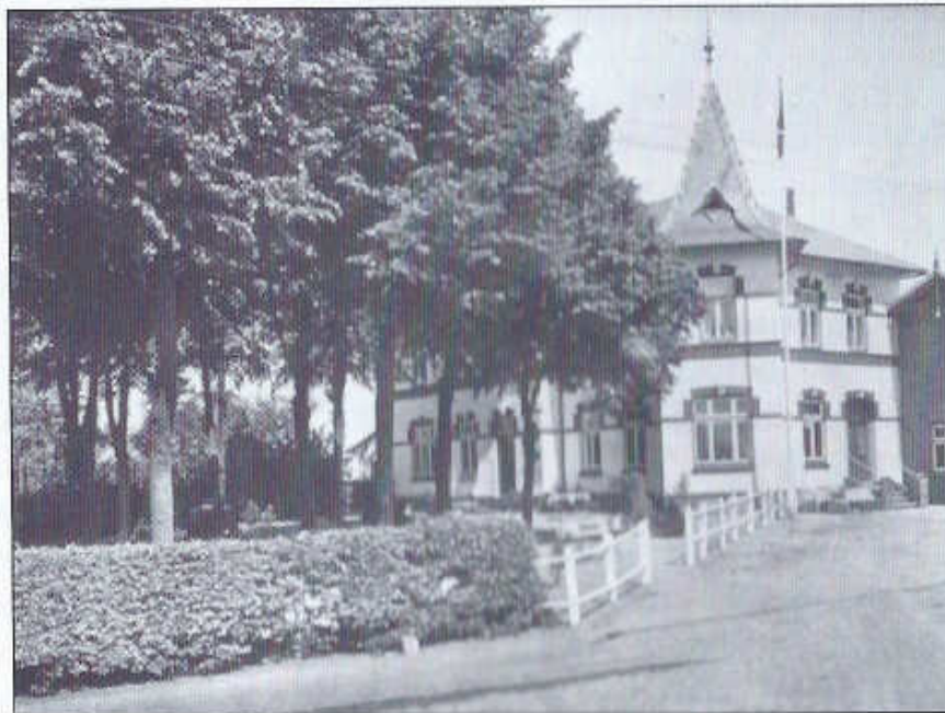
Dorfkrug „Zur Friedenseiche“ 1900 erbaut. Lange Zeit fehlte die Turmspitze. Nach dem Umbau 1996 prä- sentierte sich das traditionsreiche Haus in alter Form.
