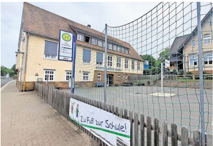
Die Wichtelhäuser Schule in Sterzhausen hat eigentlich ihre Zeit erreicht. Von einem Neubau ist aber derzeit immer nur die Rede, konkrete Pläne dazu sind öffentlich jedenfalls nicht bekannt. FOTO: SCHAUB
