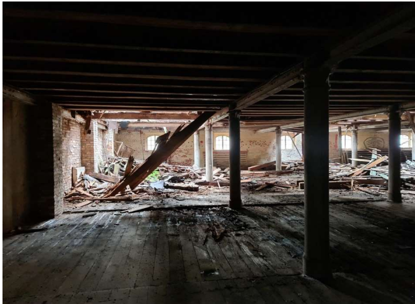
Bild 13: Innenansicht Zustand Mälzerei-Gebäude April 2023
