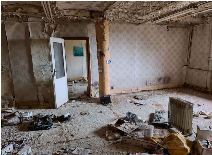
Bild 14: Innenansicht Zustand Mälzerei-Gebäude April 2023
