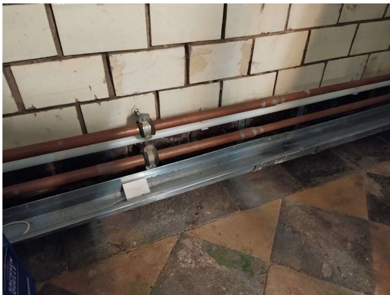
Bild 6: Sockelheizung im Depotbereich der Stiftung Bauhaus Dessau.
