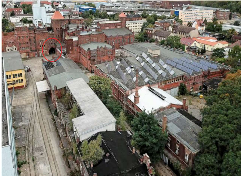
Bild 15: Blick auf die ehemalige Anlieferung der Schultheiss-Brauerei
