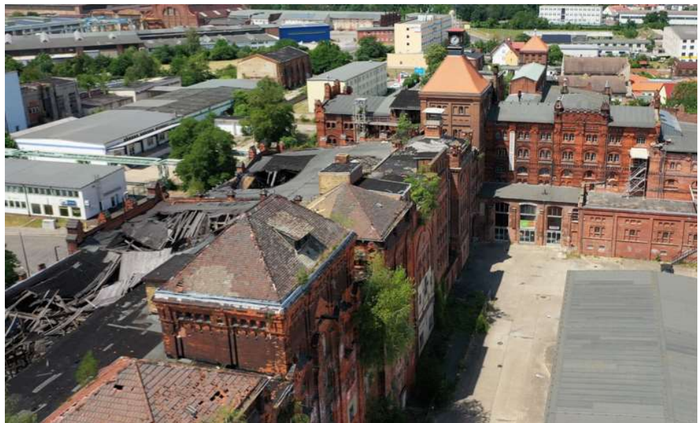
Bild 12: Zustand Mälzerei-Gebäude April 2023
