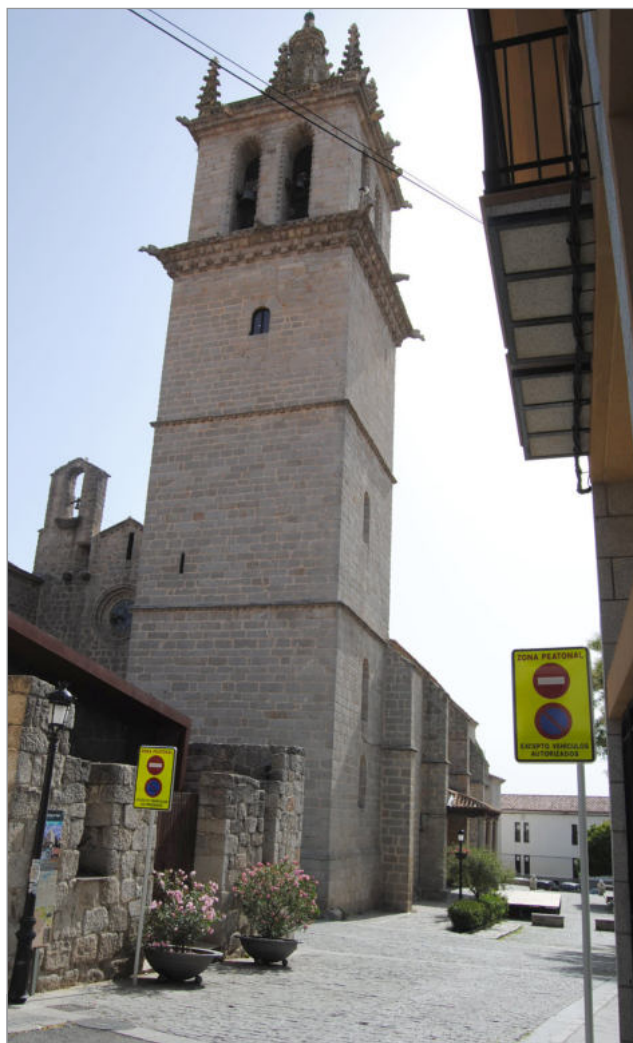
Figura 3 Placas de tráfico afectando la visual urbana, contraviniendo lo establecido para el perímetro de protección de los monumentos declarados Bien de Interés Cultural, como ocurre con la Basílica menor de la Asunción de Ntra. Sra.
