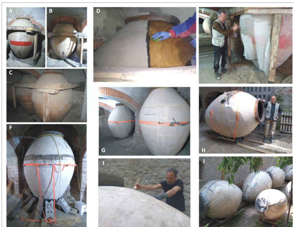
Figura 3. Distintas fases de la intervención. a, b y c, estado inicial; d, limpieza; e, consolidación y protección; f y g, preparación para el tumbado y extracción; h, extracción de las tinajas; i, conclusión de la fase de protección; j, estado final de las tinajas tras la extracción y almacenaje.
