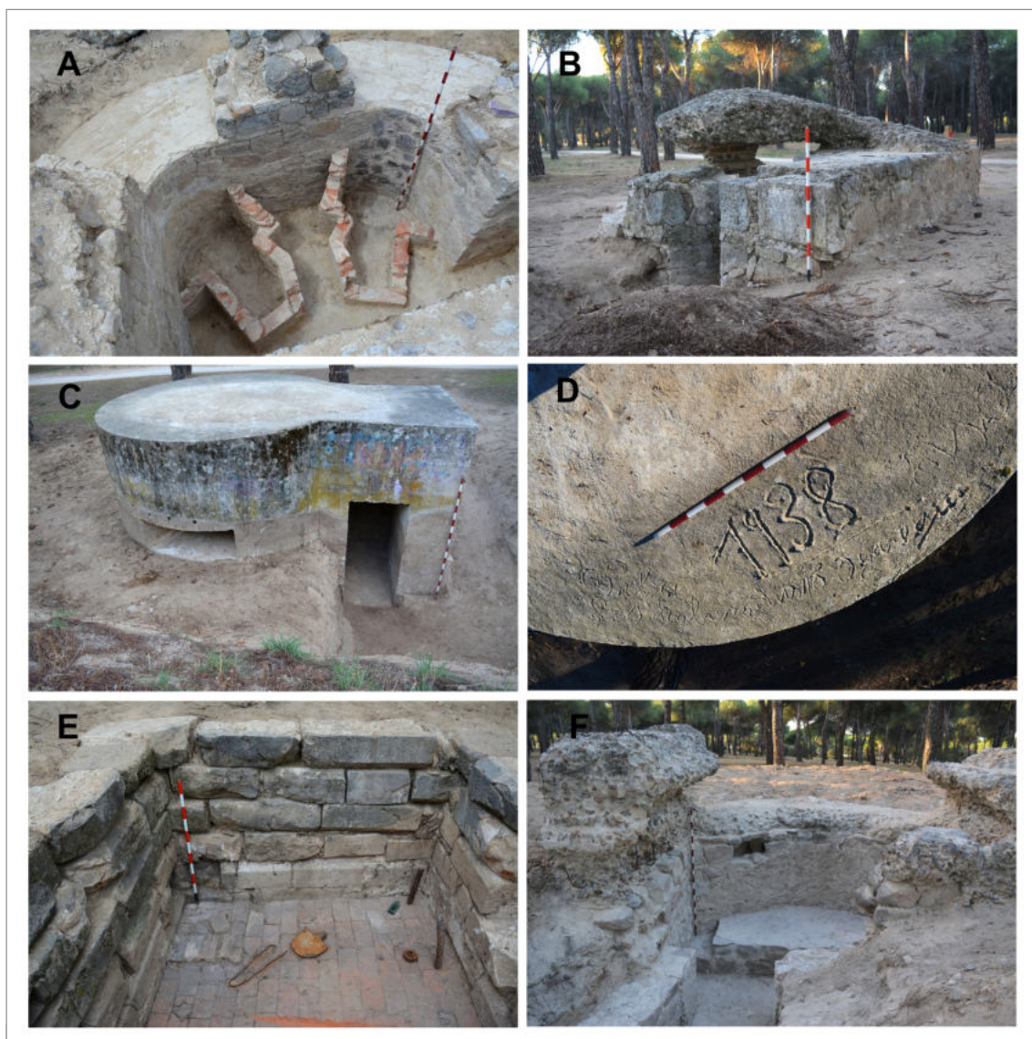
Figura 2: A-fortín para fusil ametrallador. B-fortín de mampostería para arma automática. C- nido de ametralladora de hormigón armado. D-inscripción en la cubierta del anterior nido de ametralladora. E- puesto de mando con objetos hallados sobre el solado. F- Observatorio.
