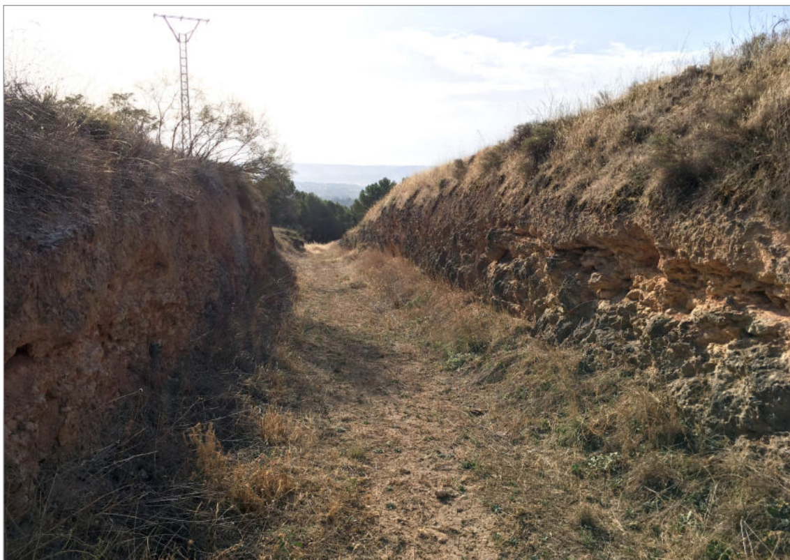
Figura 2. Vista general de la calzada de acceso en su punto más elevado.
