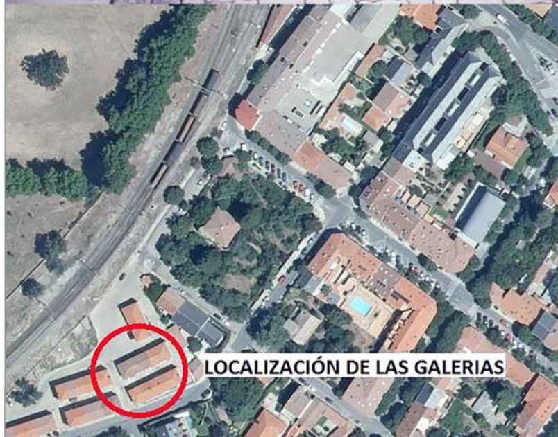
Figura 1. Hundimiento de la calle Nuestra Señora de la Herrería y localización.
