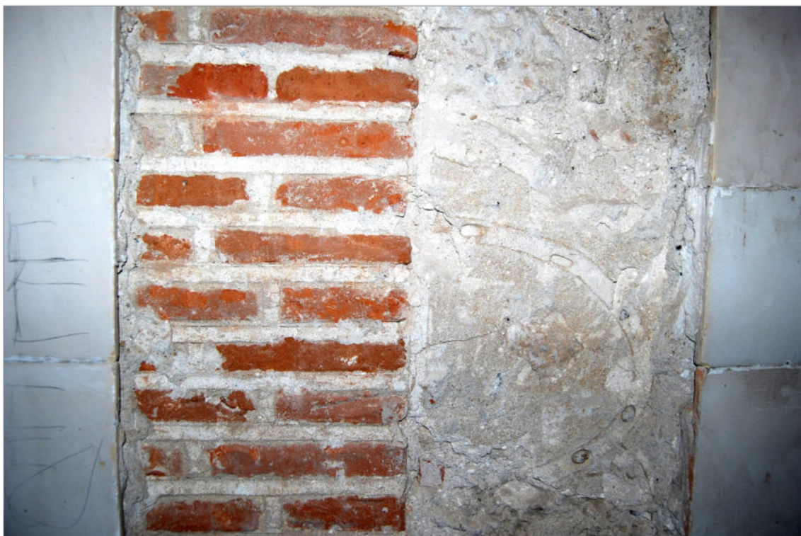
Figura 1. Fragmento de la fachada original hacia el oeste, descubierto en una cata muraria practicada en la ampliación del edificio datada en época de Isabel II.
