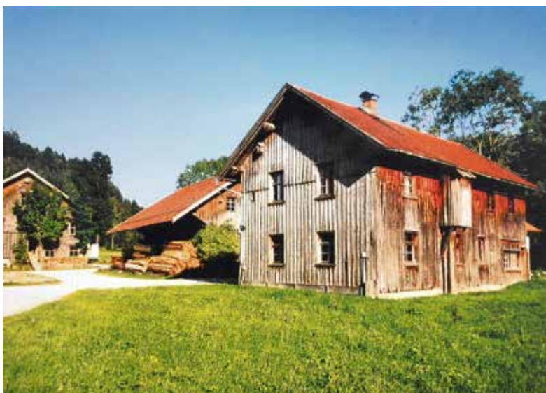
Sägerei, Wagenschuppen, Kantine und Wohnung im Obergeschoss, unten Garagen, Werkstatt.
