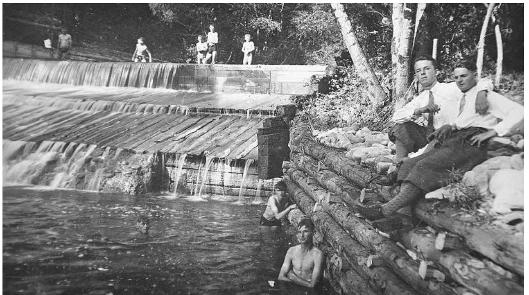
Das alte Holzwehr wurde bei einem Hochwasser zerstört und durch ein Betonwehr ersetzt. Früher wie heute wird dort gerne gebadet.
