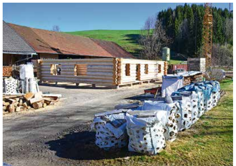
Blockhausbau bei Veser
