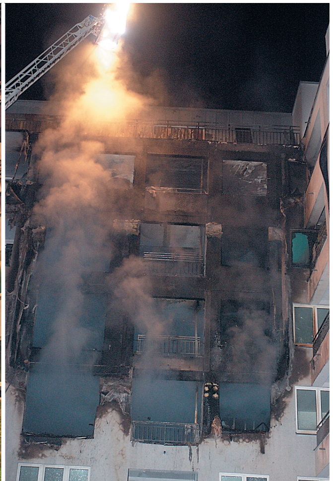
Detailaufnahme der Fassade
