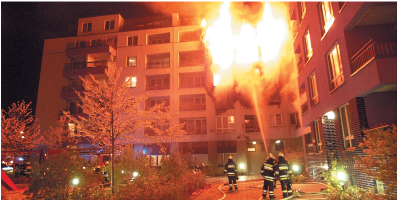
Erste Brandbekämpfung an der Gebäudevorderseite kurz nach Eintreffen der ersten Kräfte
