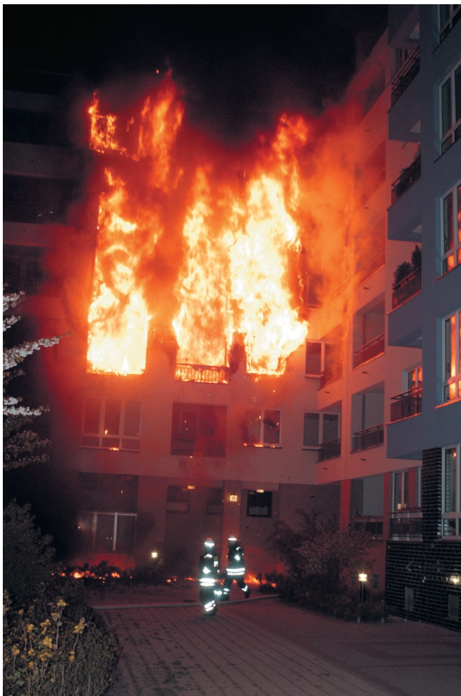
Die Situation unmittelbar nach Eintreffen der Feuerwehr: Die Fassade steht bereits in Vollbrand.
