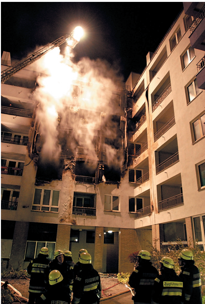
Deutliche Brandspuren an der Vorderfassade
