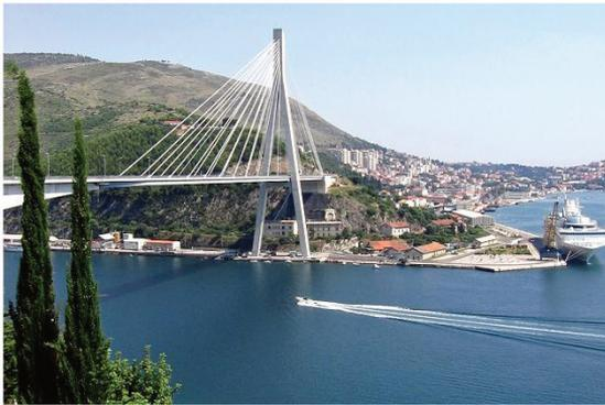
Die Franjo-Tuđman-Brücke bei Dubrovnik in Kroatien wurde 2005 an den 38 Schrägsellen mit aktiven Dämpfer ausgestattet
