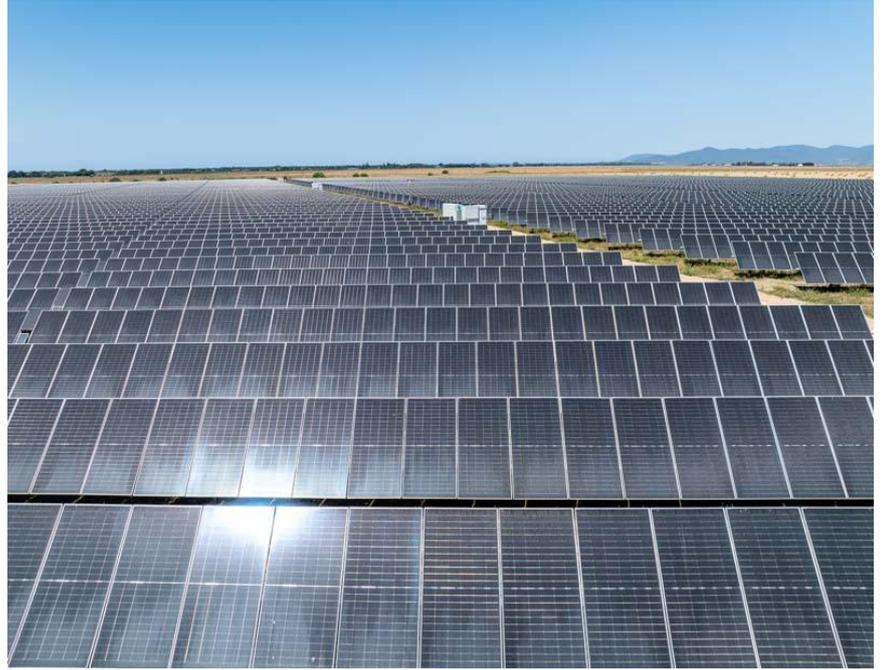
das vom Boden oder von den an die Anlage angrenzenden Flächen auf den unteren Teil der Paneele reflektiert wird, nutzen. Die gewählten Module zeichnen sich durch eine höhere Lichtempfindlichkeit aus: Sie sind daher in der Lage, selbst an bewölkten Tagen eine Stunde mehr grüne Energie pro Tag zu produzieren als andere Modelle.
