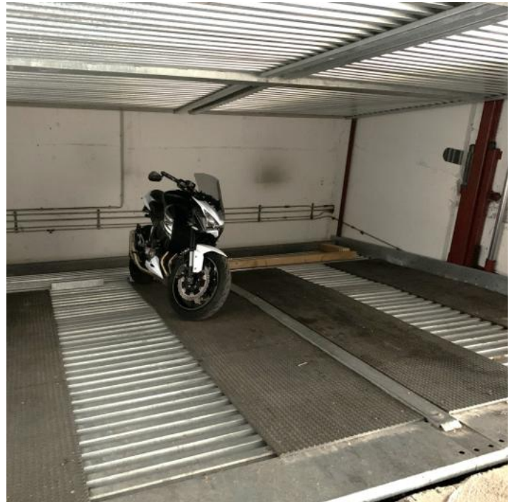
Doppelparker für 2 Autos oder 8 bis 10 Motorräder
