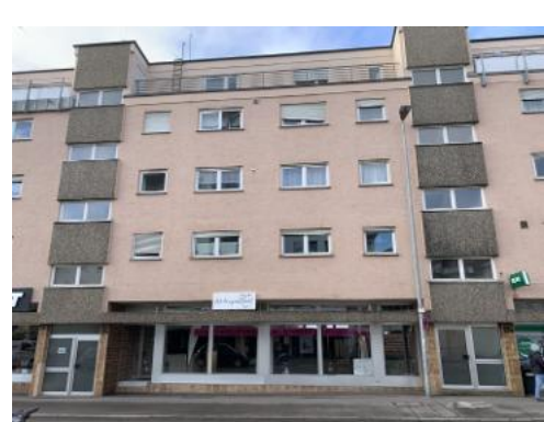
Gebäude Feuerbacher Straße 15/1, Leonberg
