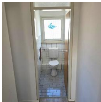
WC im aktuellen Zustand
