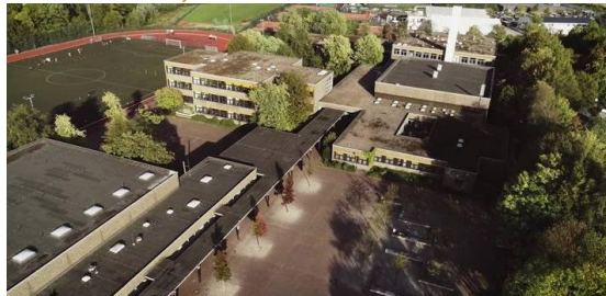
Heinrich-Heine-Gymnasium - Sportkomplex, Mettmann
