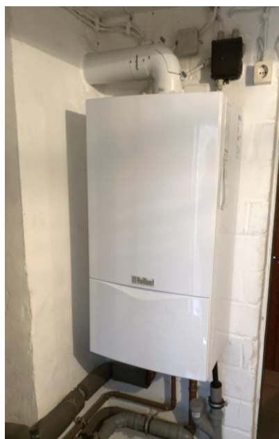
Vaillant-Brennwertkessel
