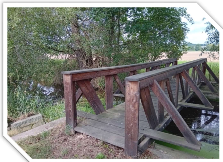
Ansicht: Schäferbrücke Loga
