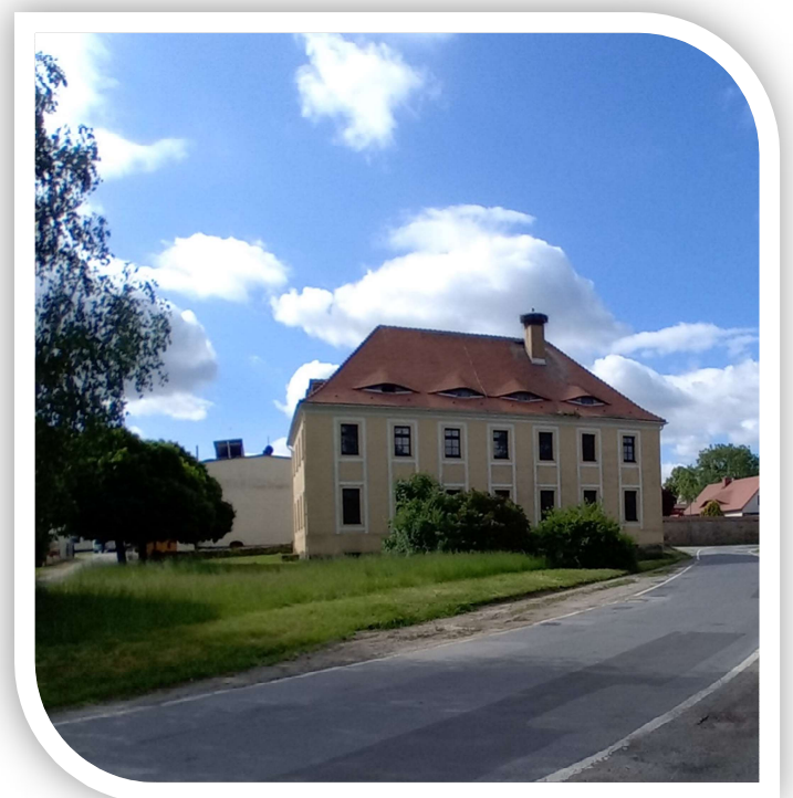
Ansicht: Herrenhaus Loga, Nordseite
