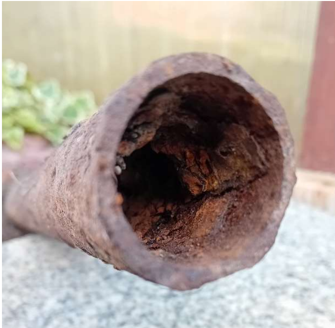
Abbildung 1, Foto, alte Wasserleitung von 1926
