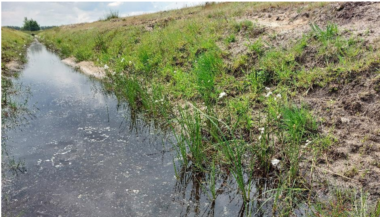
Abbildung 4-21: Teilaspekt des Grabens in der PVA Georgsdorf
