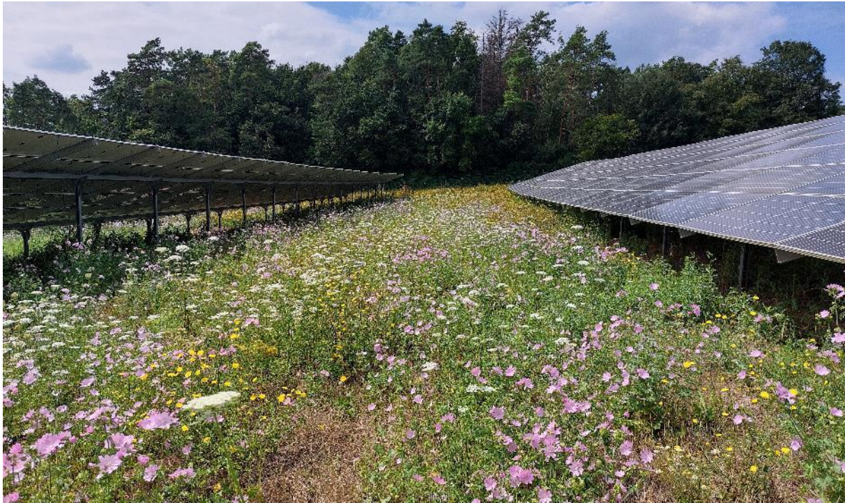
Abbildung 4-26: Zwischenraum zwischen den Modulreihen am Beispiel der PVA Maßbach, Bayern
