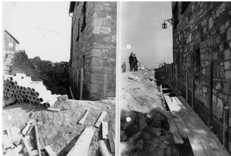
Trainagen-Entwässerung der Kemenate, Wandisolierung und Stützbeton
