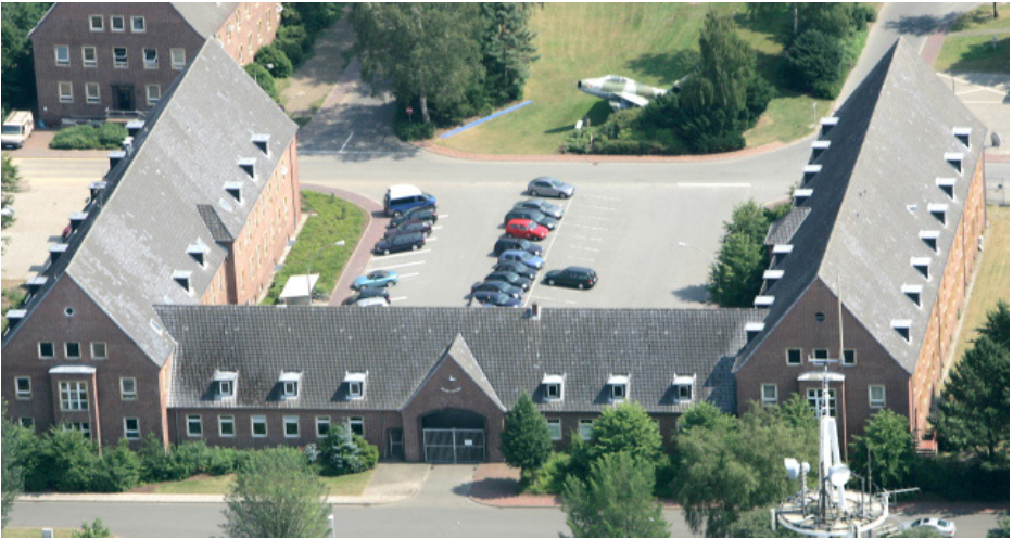
Das Stabsgebäude des Flugabwehrraketengeschwaders 1 mit der alten Toreinfahrt zur Fliegerhorstkaserne in der Flensburger Chaussee
