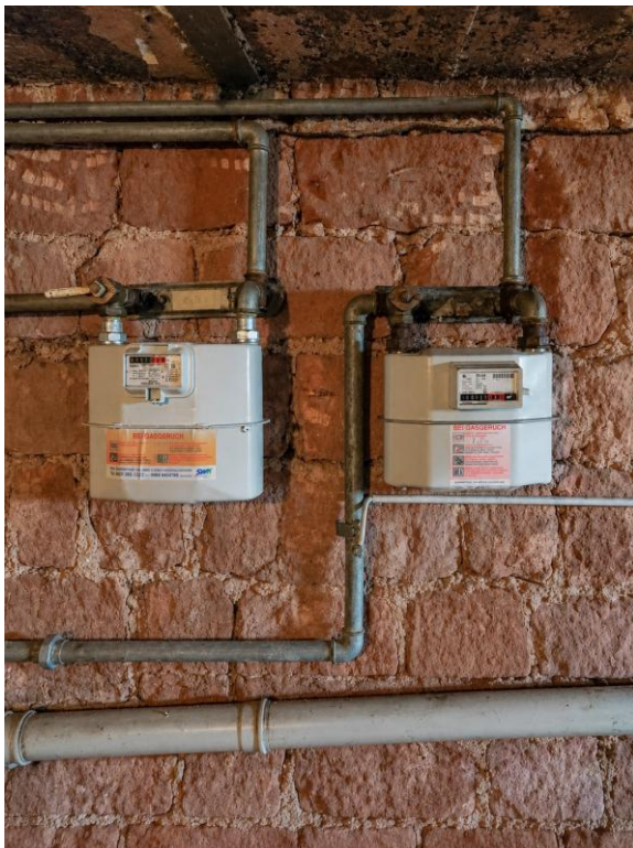
HAUSANSCHLUSS / GASZÄHLER
