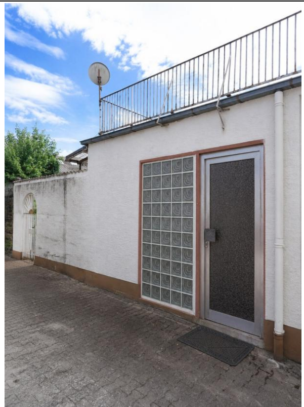
Anbau mit Dachterrasse
