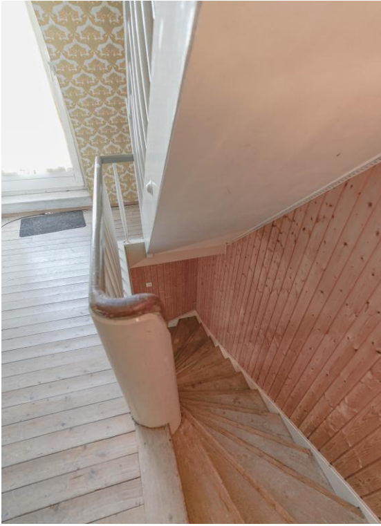
Ansicht Flur OG
