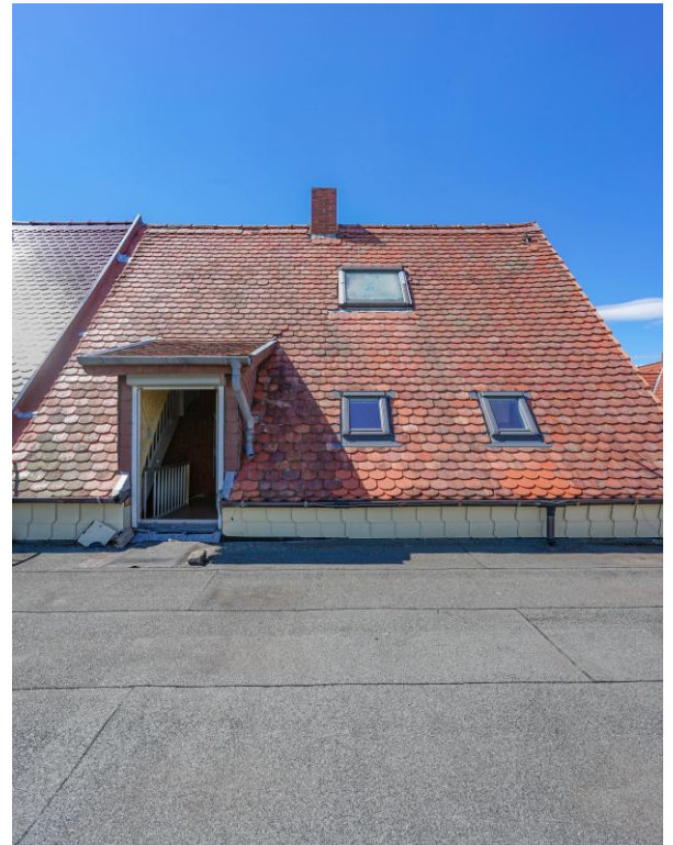
Ansicht Dach mit Dachflächenfenster
