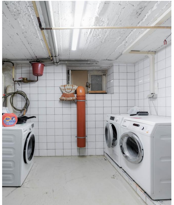
UG – Wasch- und Trockenraum
