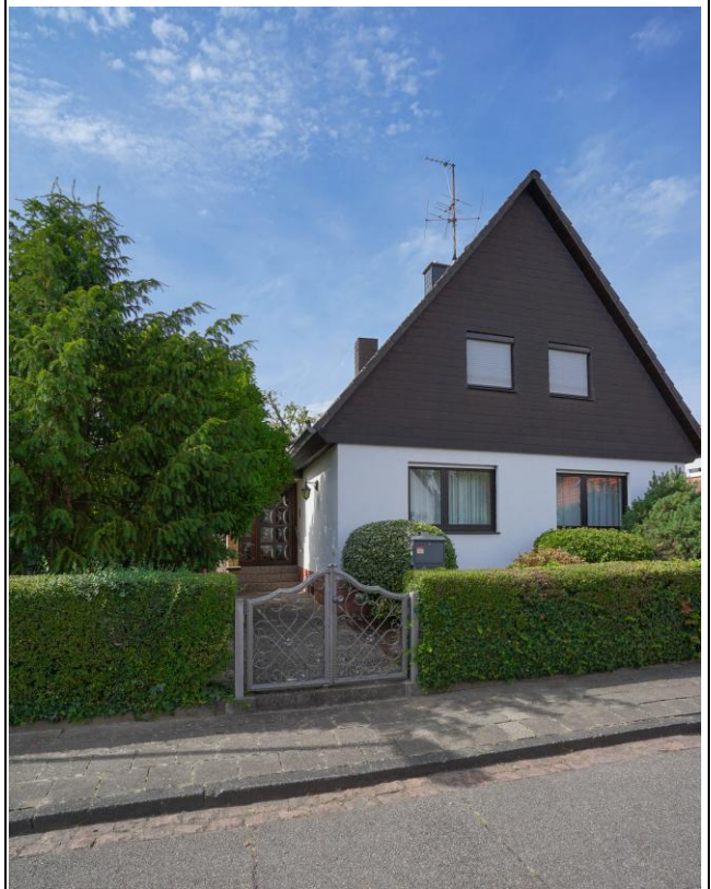
Seitenansicht mit Eingang
