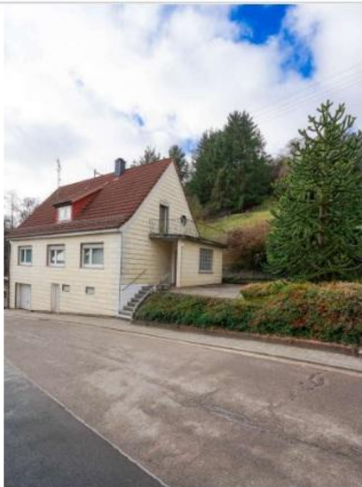
Anbau mit Windfang
