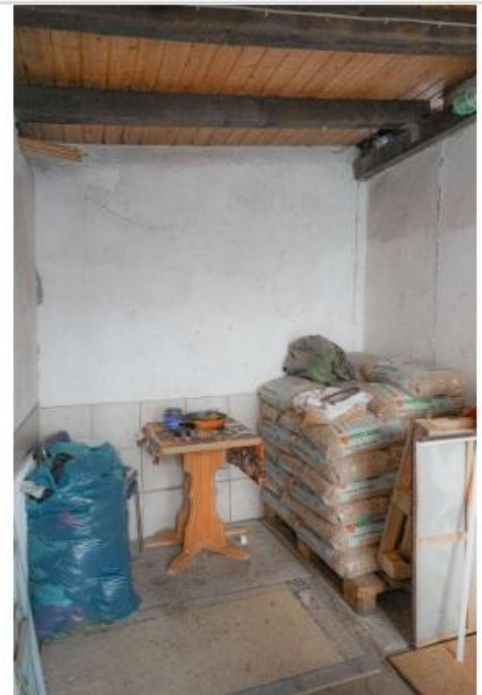
Sitzbereich zur Wohnung 2
