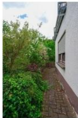
Seitenansicht / Zugang ELW
