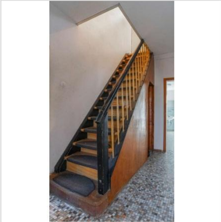
Treppe zu DG
