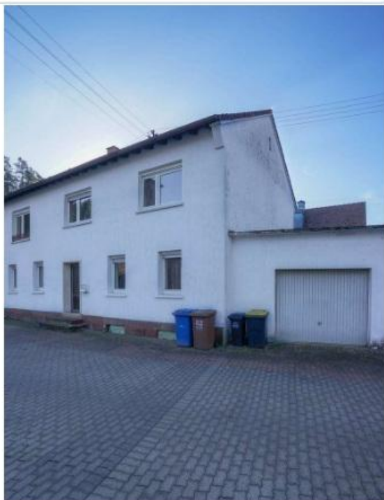
Hausansicht mit Garage
