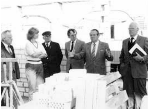
Grundsteinlegung der Mehrzweckhalle in Scheveemoor am 19.08.1982
