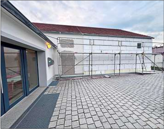
Der Gemeinderat bewilligte 2610 Euro Zuschuss für Verputzarbeiten an der Turnhalle der DJK Schönfeld. Foto: Carina Schimmer
