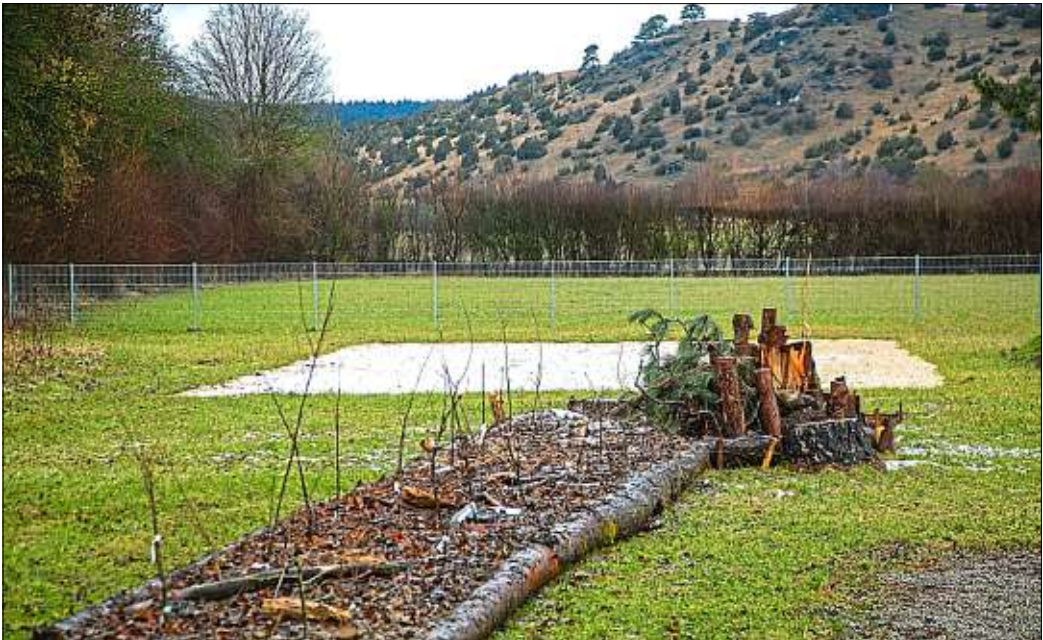
Die Stellfläche für das Holzgebäude des Zukunftsgartens am Rieder Weiher bei Dollnstein ist vorbereitet. Der Landkreis errichtet dort einen kleinen Schulungsraum. Foto: Manfred Vökl
