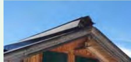
Durch massive Schneemengen der letzten beiden Winter wurde der Dachfirst unserer Gufferthütte sehr stark verformt und drohte abzureißen.
