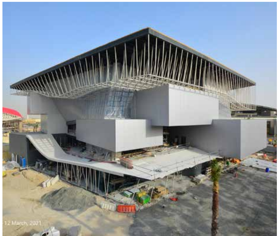
Der Pavillon im Bau
