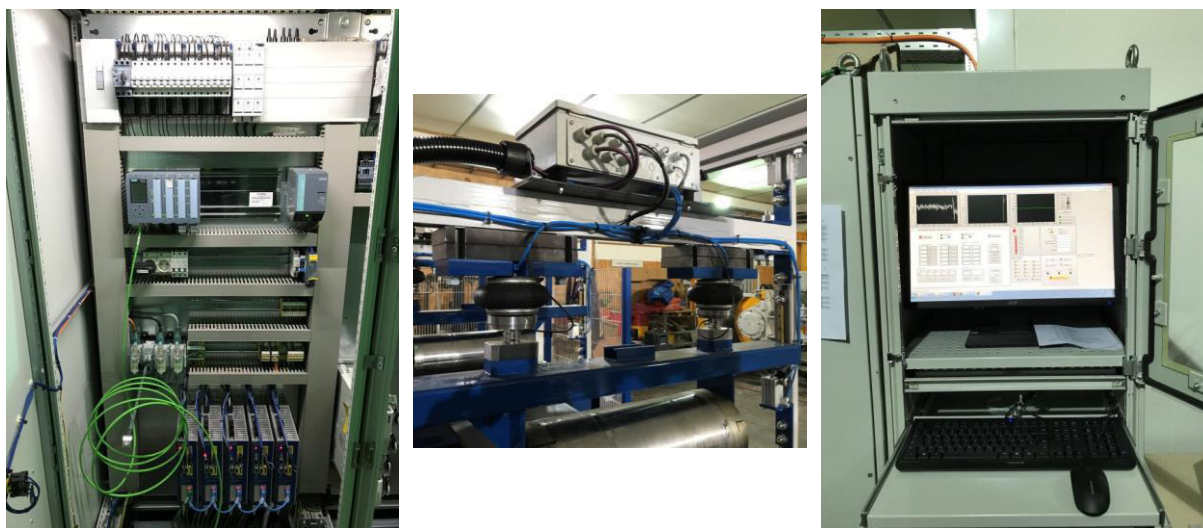
Abbildung 12: Bilder des modifizierten Prüfstands
