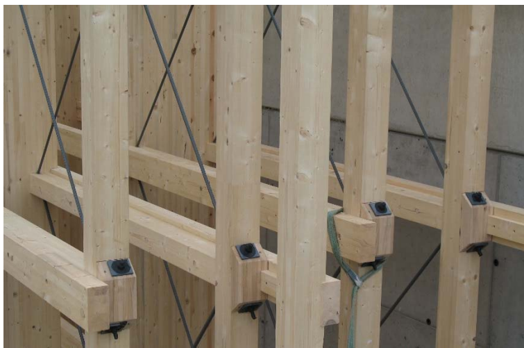
Abbildung 24: Längsaussteifungsverbände mittels Stahldiagonalen am Beispiel des Hochregallagers der (Quelle:) Salinen Austria AG
