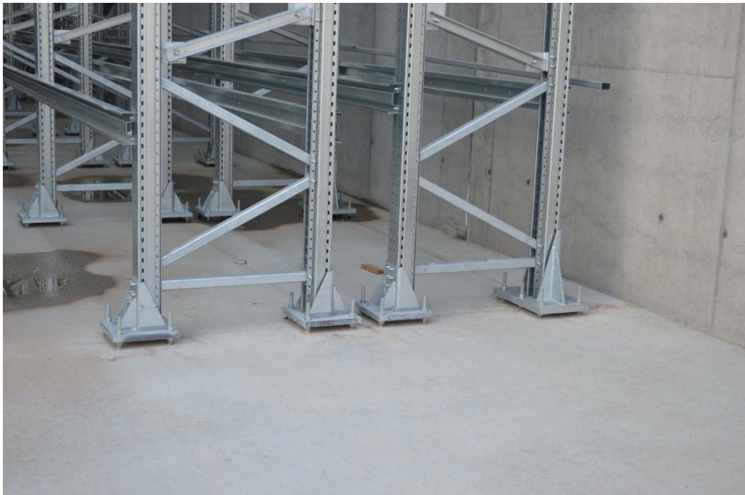
Abbildung 18: Verschraubung der Steherfüße beim Stahlregal mit der Bodenplatte, Quelle: Merz Kley & Partner ZT GmbH
