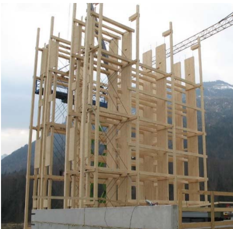
Abbildung 22: Stahl-Auskreuzungen mit anschließender Regalkonstruktion am Hochregallager der (Quelle:) Salinen Austria AG
