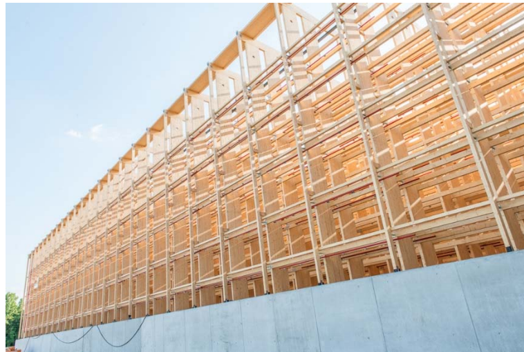
Abbildung 29: Vorsatzkonstruktion zur Anbringung der Fassade beim Hochregallager von (Quelle:) Alnatura GmbH
