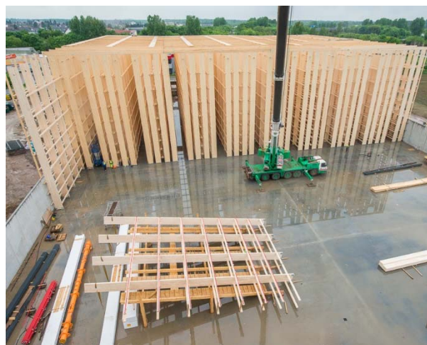
Abbildung 28: Lagerquerrichtung und liegende Montage eines Moduls in einer Schablone des Paletten-Hochregalsilos von (Quelle:) Alnatura GmbH
