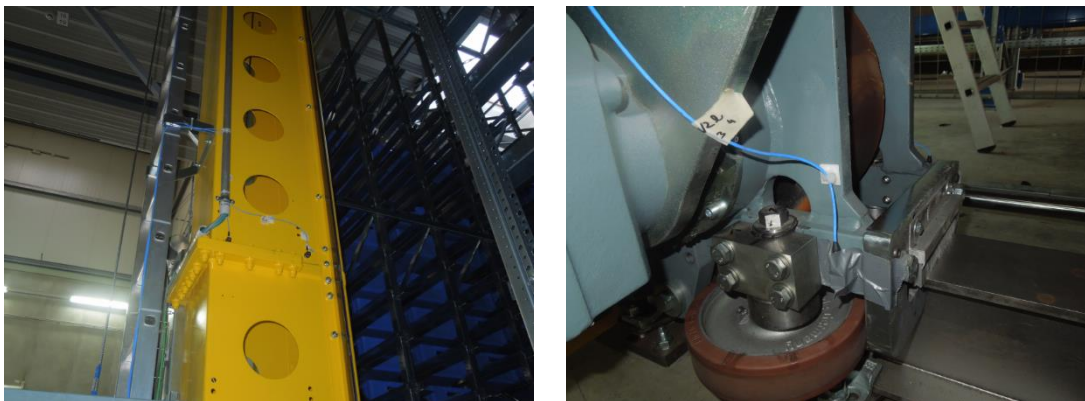
Abbildung 13: links: Beschleunigungssensorik in der Höhe des Maststoßes; rechts: Beschleunigungssensorik neben einer der unteren seitlichen Führungsrollen
