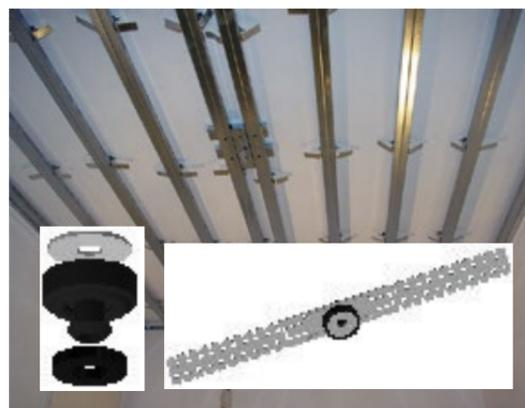
Zwischen die Direktabhängiger u. der Betondecke oder einer Decke aus Metall müssen Entkopplungselemente eingebaut werden.
