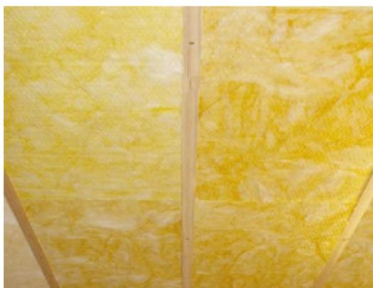
Bei einer Unterkonstruktion aus Holz ist die Dicke der Isolierung so zu wählen, dass diese mit der Unterkante der Lattung abschließt. Der Abstand der Lattung zueinander, ist der Breite der ausgewählten Folien anzupassen.
