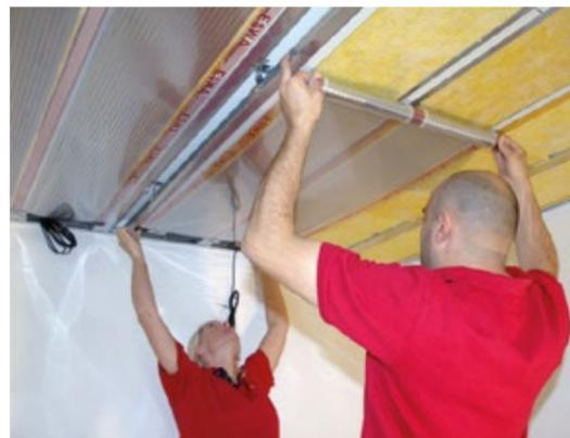
Bei einer Unterkonstruktion aus Metall sind die Heizfolien mit einem doppelseitigem Klebeband zu befestigen. Die Befestigung erfolgt an den Rand- und Mittelstreifen.
