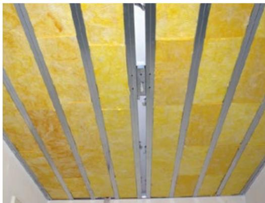
Die Dicke der Isolierung ist so zu wählen, dass diese mit der Unterkante der Tragekonstruktion abschließt. Der Abstand der Metallprofile zueinander, ist der Breite der ausgewählten Folien anzupassen.
