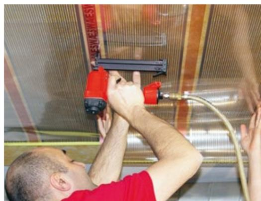
Bei einer Unterkonstruktion aus Holz, klammern Sie die Heizfolien an den Rand- und Mittelstreifen an der Lattung fest.
