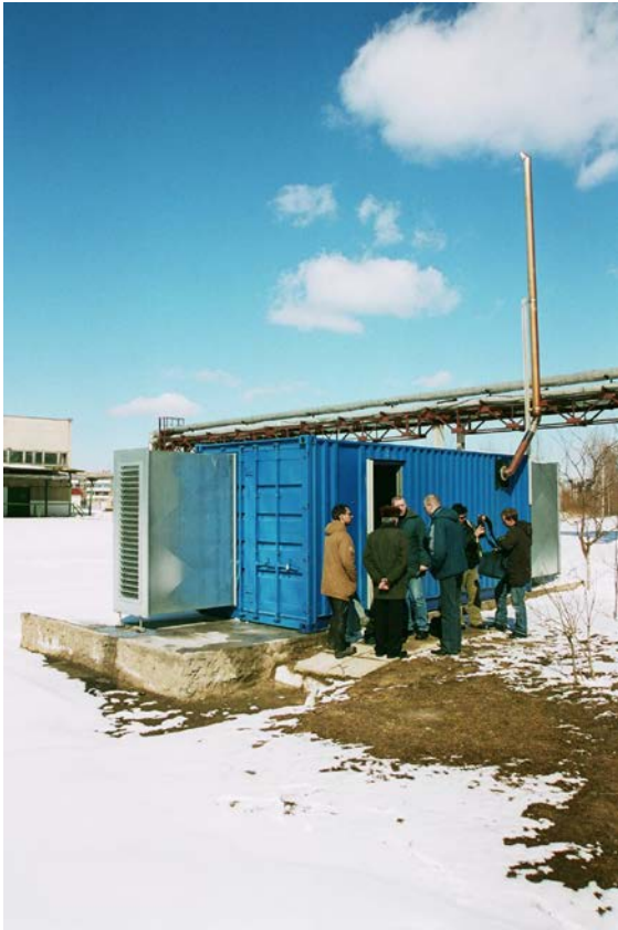
OHSI-Projekt BHKW (300 kVA el.) in Choiniki mit Rapsöl aus der Tschernobyl-Sperrzone als Treibstoff (2006)
