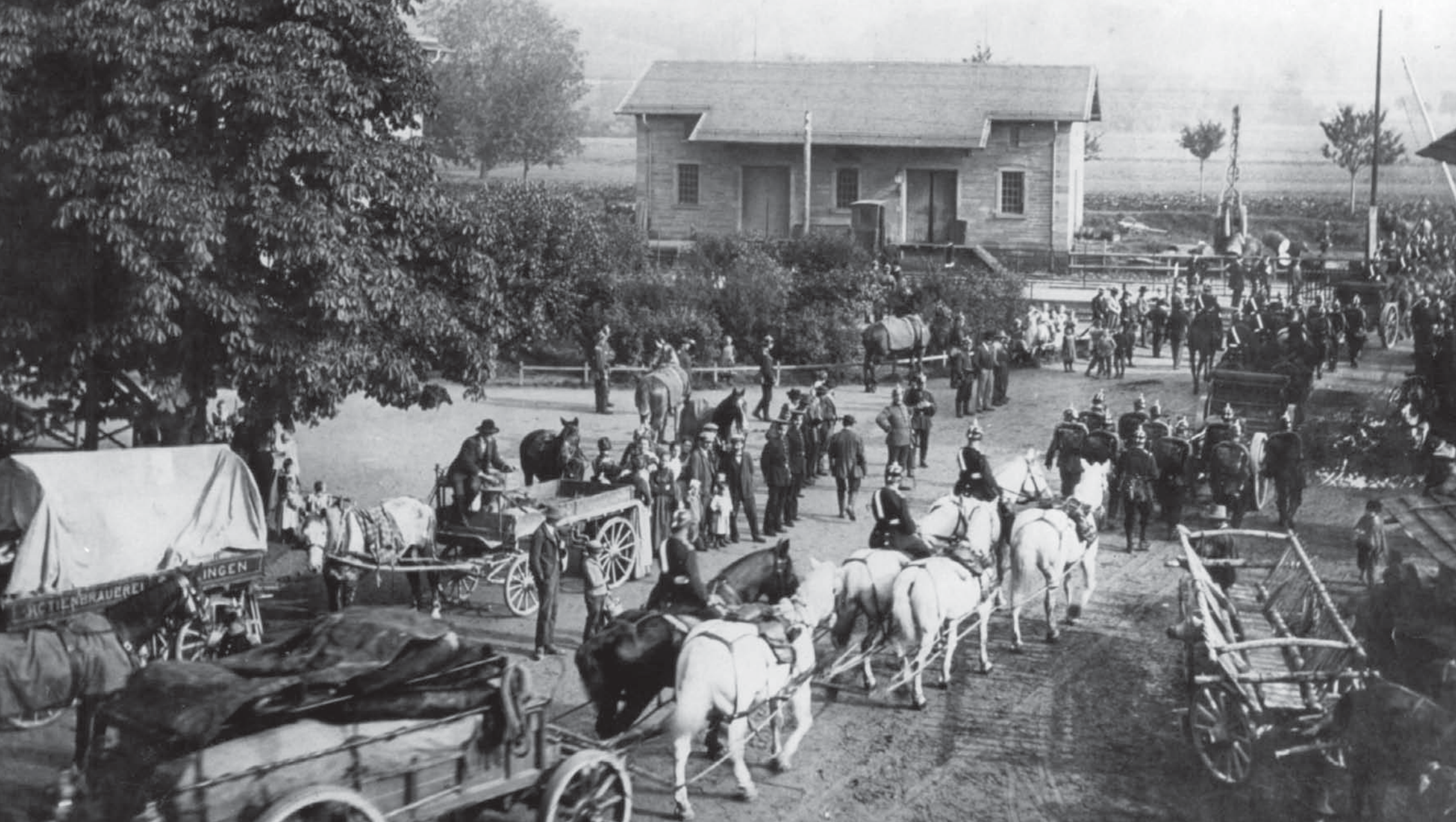
Efringen – 1913 Kaisermanöver, Bahnübergang am Bahnhof Efringen
