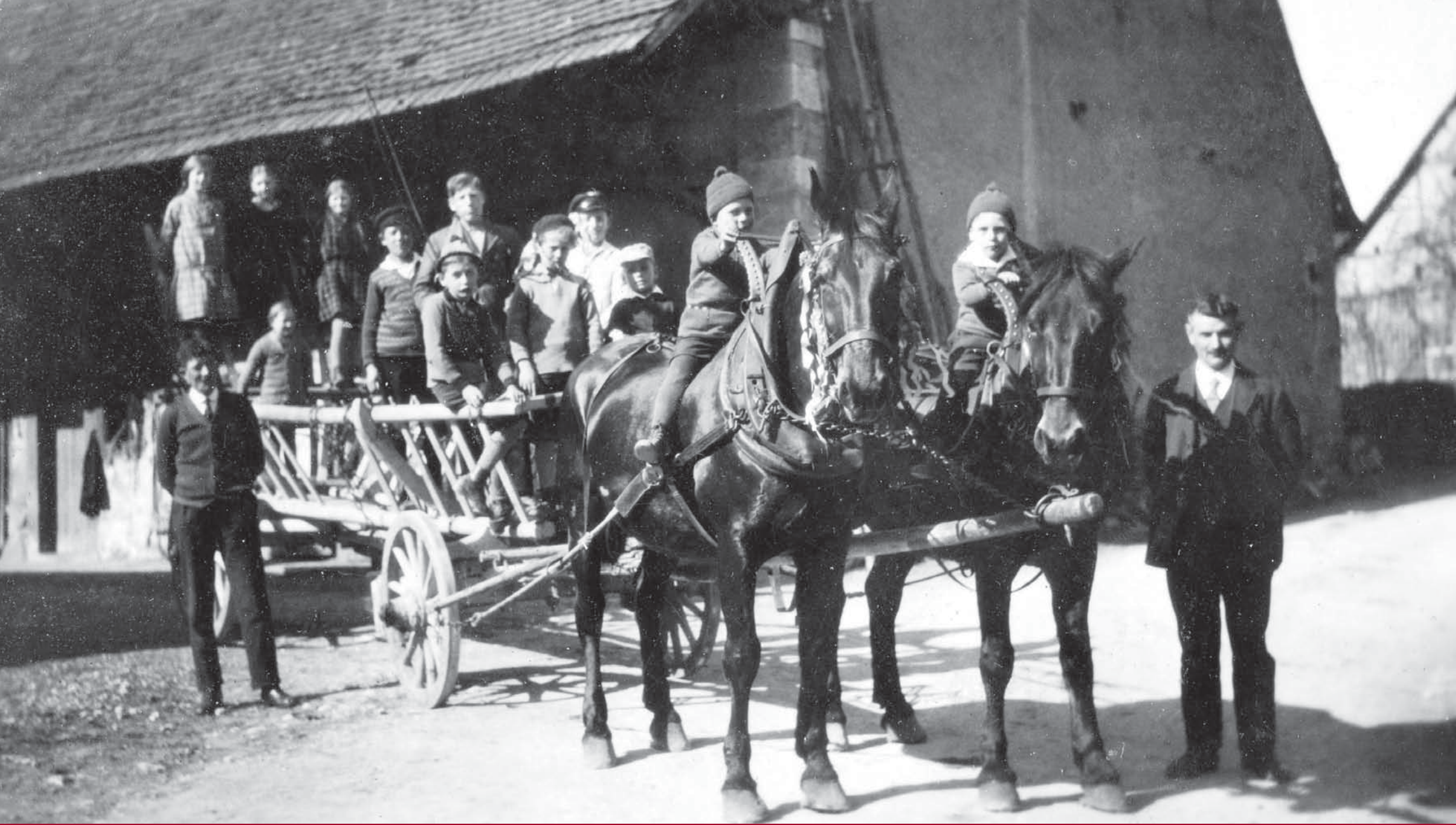
Wintersweiler – Im Hof der Familie Lang, Hintere Dorfstraße 7, ca. 1930.
