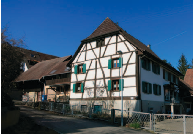
Brunnenplatz 4 (rechts) 6 (links)
