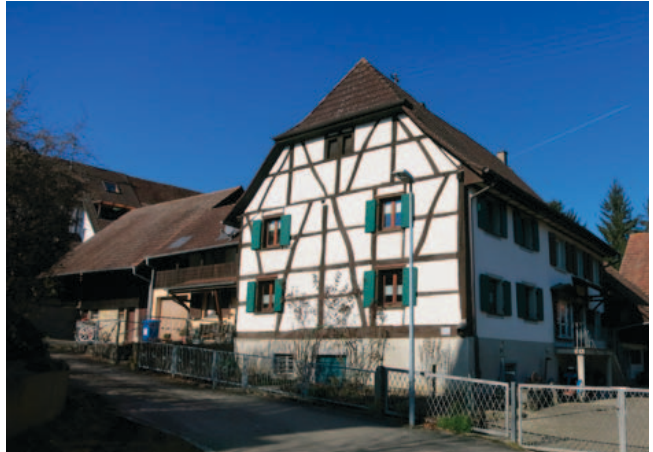
Brunnenplatz 4 (rechts) 6 (links)
