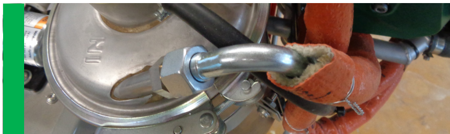
Der Feuerschutzschlauch bedeckt den Gummischlauch komplett / the fire protection hose completely covers the rubber hose
