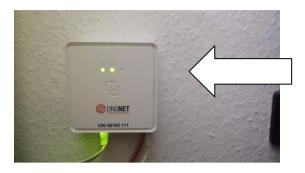
In einem 1.Schritt wird der Blinddeckel der Zugangsbox entriegelt (Pfeil) und mit einer Viertelumdrehung gegen den Uhrzeigersinn entfernt.
