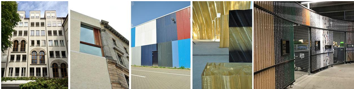
Figure 19. Kloostergarten Lehel, Munich; Gallery Am Kupfergraben, Berlin; recycling centre Kringloop Zuid, Maastricht; 3d Printed Canal House, Amsterdam; Nærgenbrugstation, Copenhagen.
