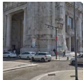
Varco Galleria Ovest
