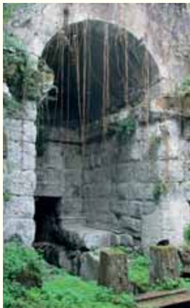
La galleria di scarico realizzata dai Romani nel 394 a.C per regolare il livello del Lago Albano
